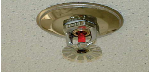
Figura 22: Chuveiro automático
