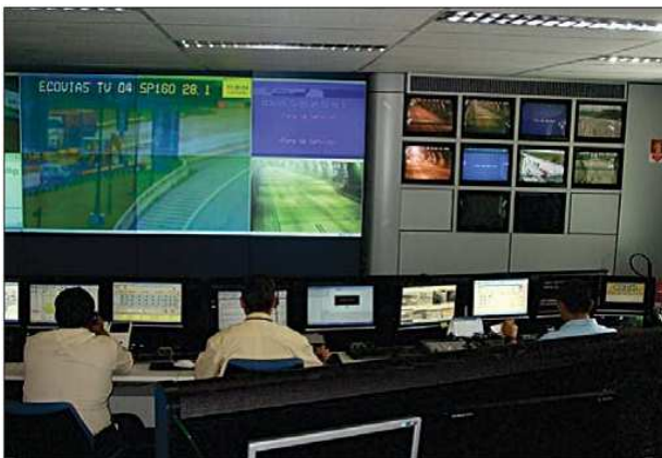
Figura 3: Central de monitoramento
