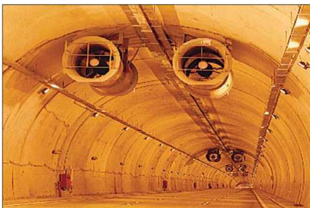
Figura 1: Sistema de ventilação longitudinal
