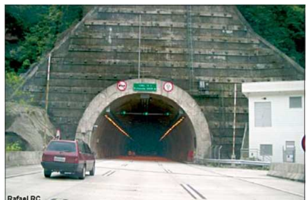
Figura 2: Sinalização na entrada do túnel
